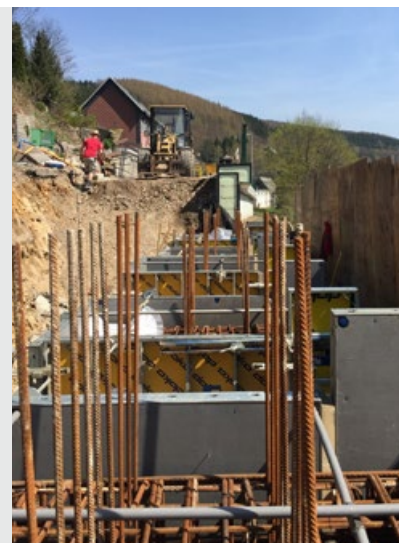
Fundamentarbeiten für den Neubau der Straße und der Hangsicherung.
