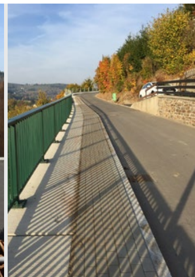
Die neue Straße nach Abschluss der Baumaßnahmen. Mit Autodesk Civil 3D konnte IBL in der Planung Zeit und Kosten sparen.
